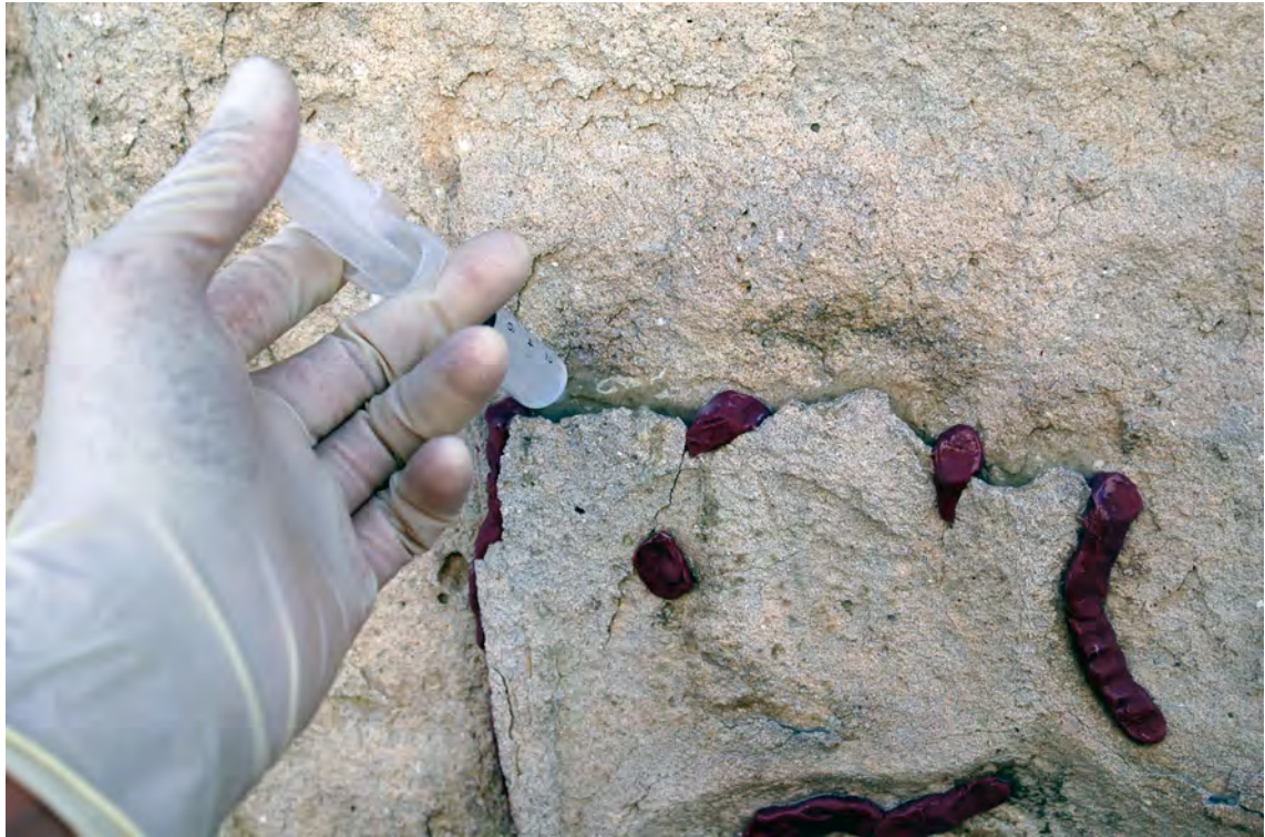
Làmines 11-13. Consolidació de l'escut heràldic dels Bernat situat a la casa de la família Rico.
