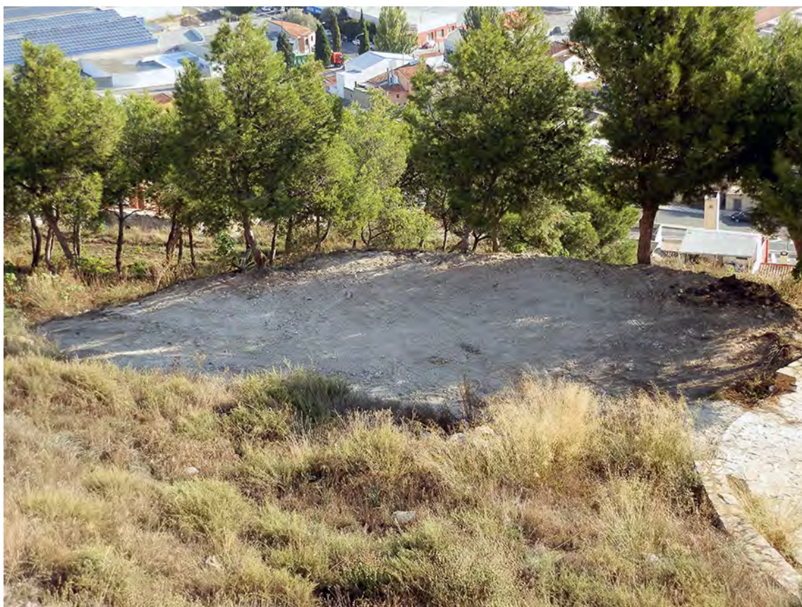
Làmines 21 i 22. Retirada d'enderrocs.
