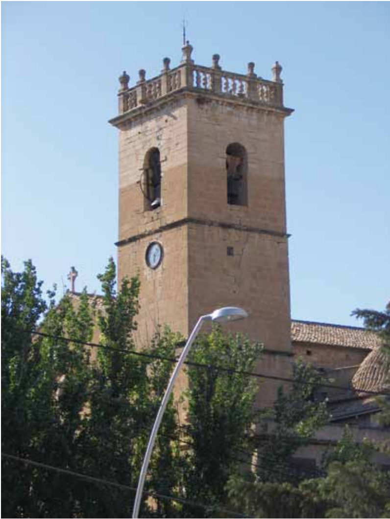
Lámina 6. La torre campanario sin restaurar.
