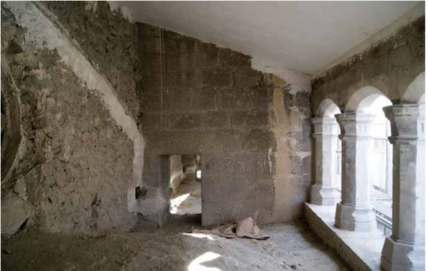
Lámina 5. Galería sobre las bóvedas de la fachada noroeste.
