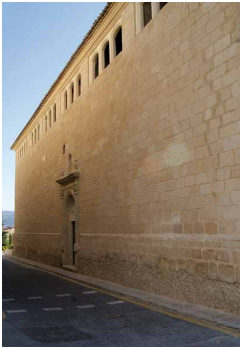
Lámina 14. La fachada noroeste acabada la restauración.
