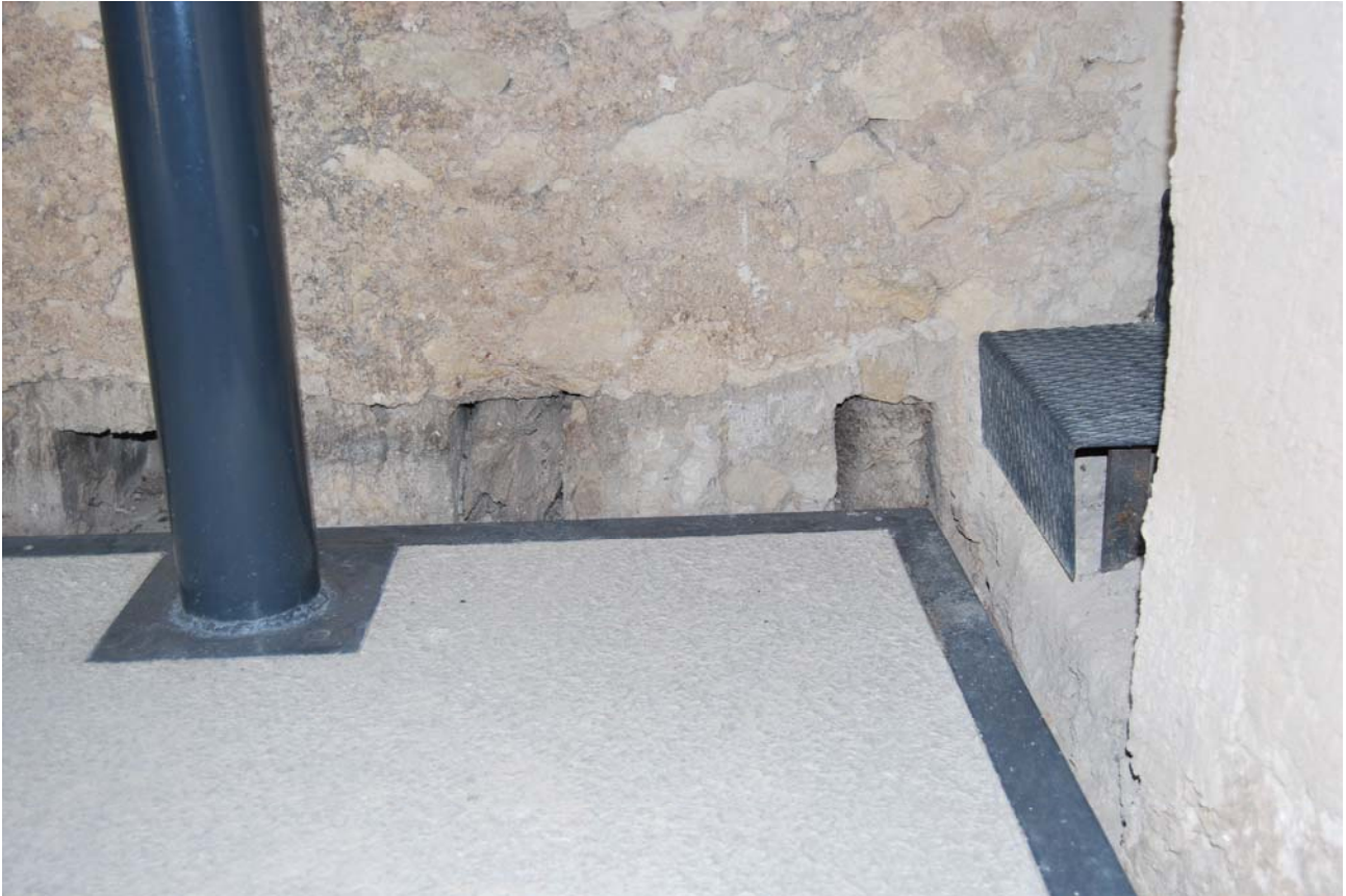
Lámina 4. Restos de las vigas de madera que formaban parte del forjado de la segunda planta del Palau.
